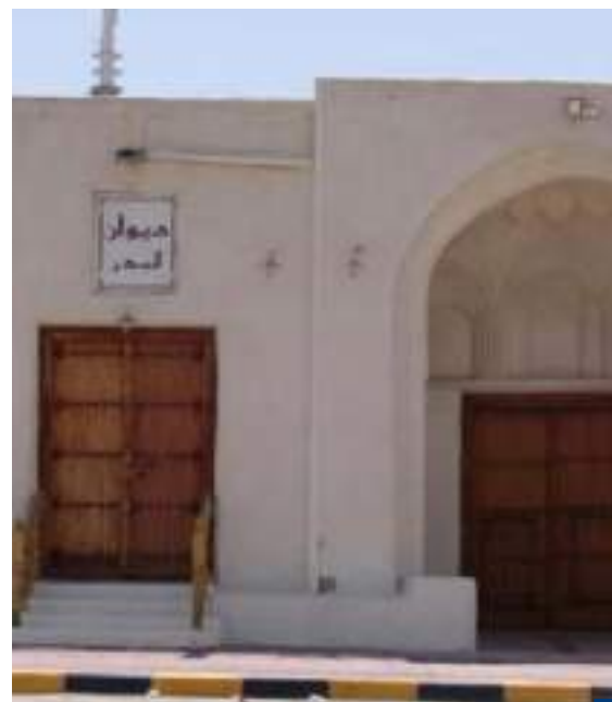
مبنى بيت البدر من الخارج
