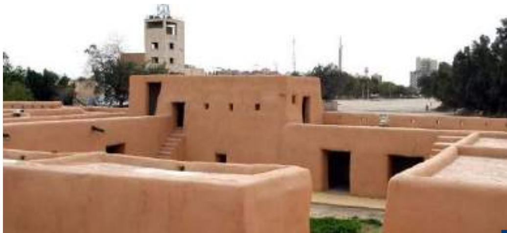
مبنى القصر الأحمر في الجهراء
