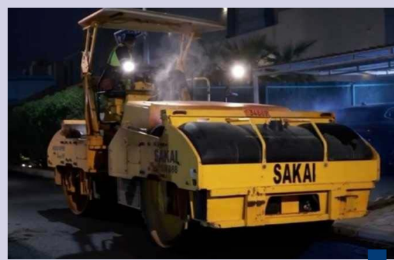
جانب من أعمال الصيانة
