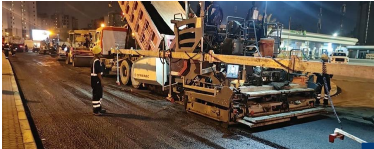
جانب من أعمال الصيانة
