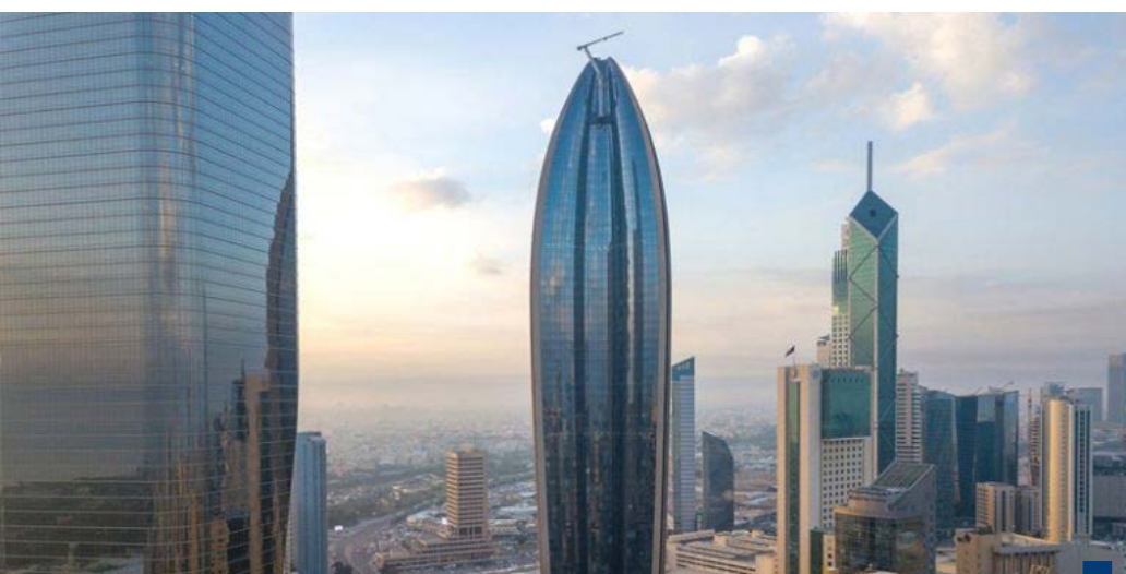
مبنى بنك الكويت الوطني
